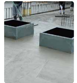
コンクリート打設
