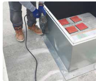
アンカー下穴加工
