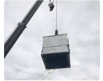
屋上搬入(クレーン)
