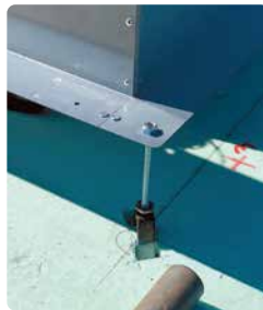
レベルアンカー固定
