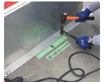
アンカー打込み
