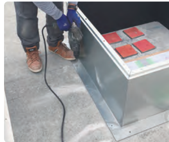
アンカー下穴加工
