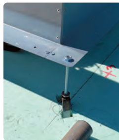
天端ポイント固定
