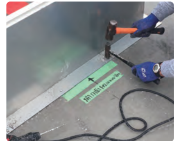
アンカー打込み
