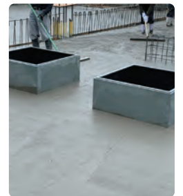
コンクリート打設
