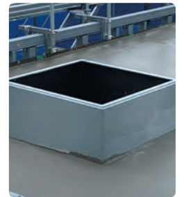
コンクリート打設
