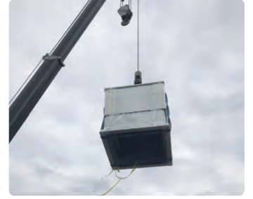
屋上搬入(クレーン)
