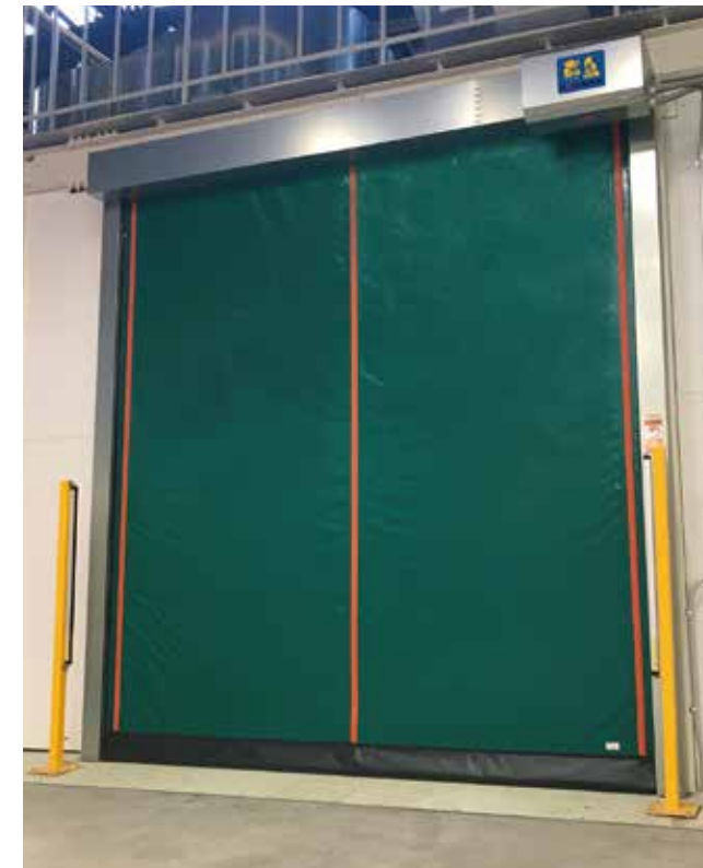
完工日/2020年2月 製品名/ROLLASKA サイズ/縦3.00m×横3.00m 場所/都内某所
