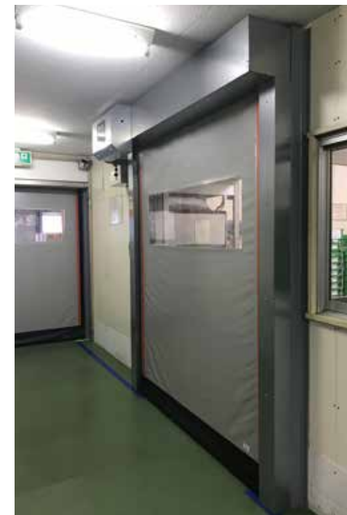
完工日/2018年10月 製品名/ROLLASKA サイズ/縦1.80m×横1.90m 場所/神奈川県内某所
