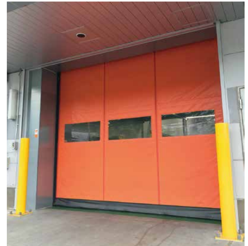
完工日/2018年7月 製品名/ROLLASKA サイズ/縦3.60m×横2.80m 場所/埼玉県内某所
