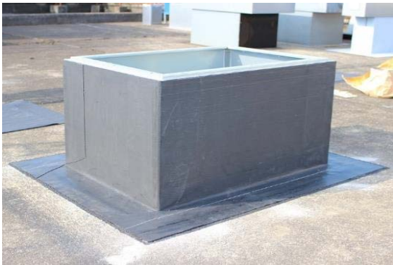
アスファルト防水材 平場1層目
