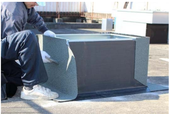
アスファルト防水材 立上がり2層目
