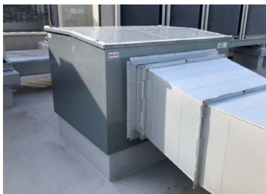
ハットボックス 据付工程終了
