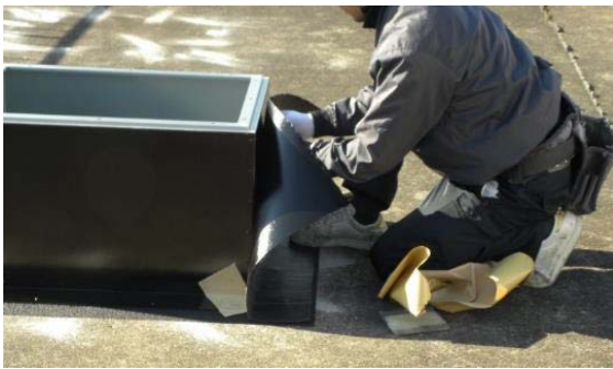
アスファルト防水材 立上がり1層目
