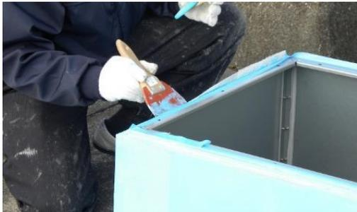
台座上部水平面に補強布を貼り付けます
