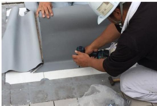
固定ネジで防水シートを下地に固定
