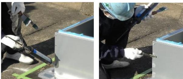
台座固定ボルト（アンカー）及びブラインドリベットにもシーリング材を塗布します
