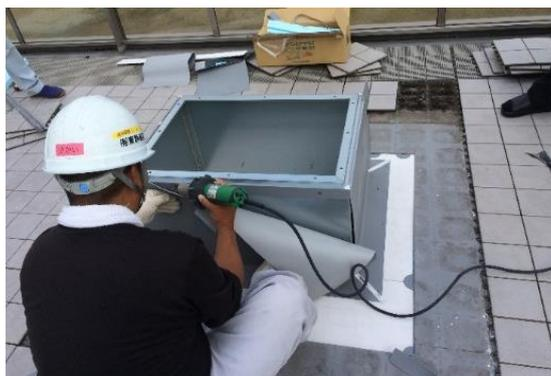
台座上部に固定した塩ビ鋼板に防水シートを溶着
